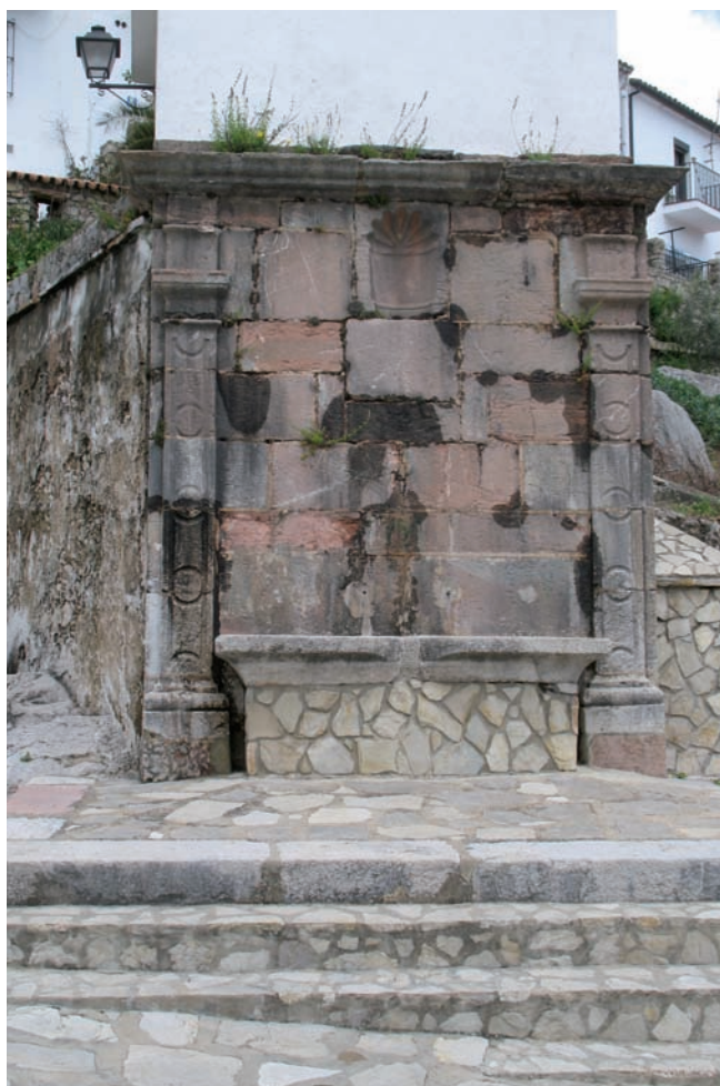
Fuente terminal del acueducto subterráneo
