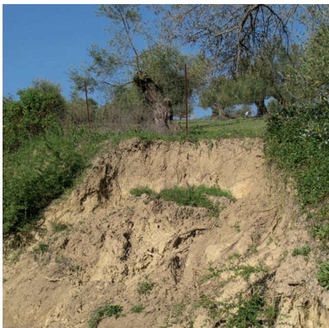
Deslizamiento en margas cretácicas. Carretera de Prado del Rey a Zahara de la Sierra
