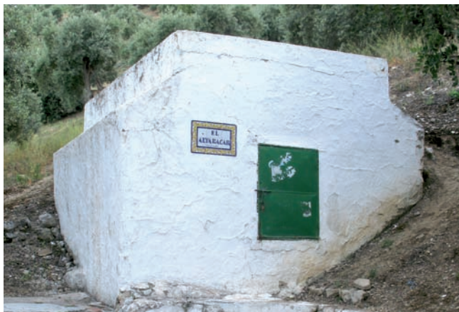
Vista de conjunto de la fuente del Altabacar
