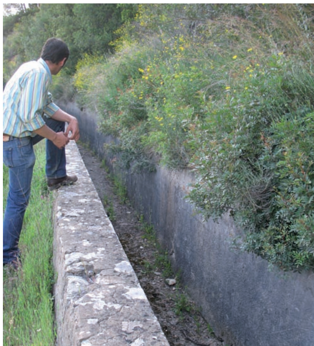
Final del canal que transportaba el agua hasta la antigua central hidroeléctrica, 64 m por encima de ella
