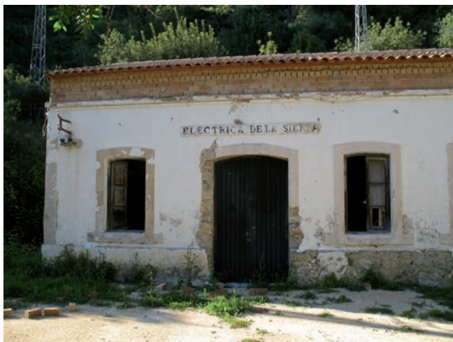
Edificio donde se alojaba la fábrica de luz "Eléctrica de la Sierra"
