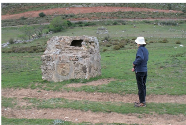
Vista de uno de los pozos menores de registro del acueducto subterráneo
