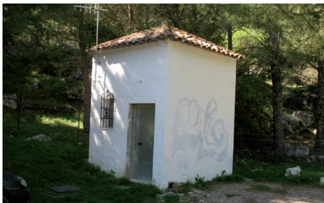
Caseta que alberga un sondeo en explotación, para abastecimiento a la localidad de Grazalema, junto al sendero de los Charcones
