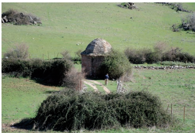
Uno de los cuatro grandes pozos de registro del qanat, junto al arroyo Albarrán
