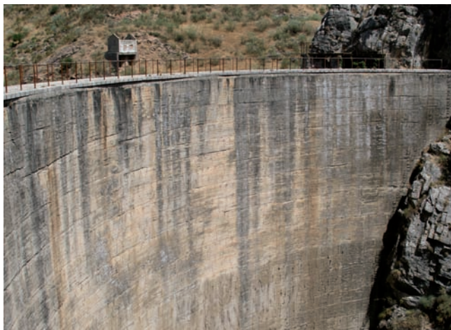
Presa de Montejaque, o de los Caballeros
